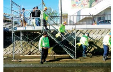
昇降仮設階段
